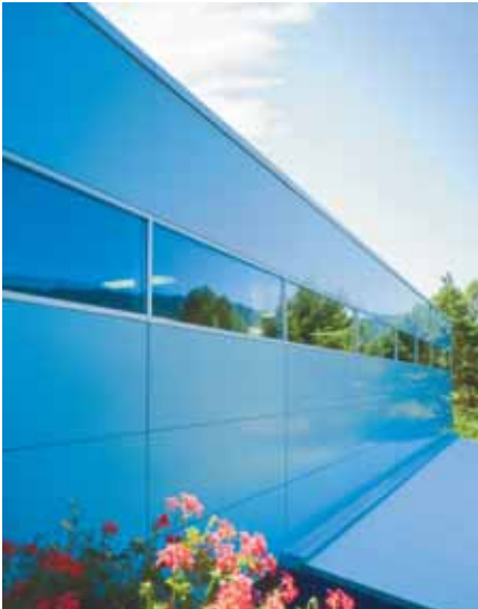
Piscina cubierta de Adliswill
