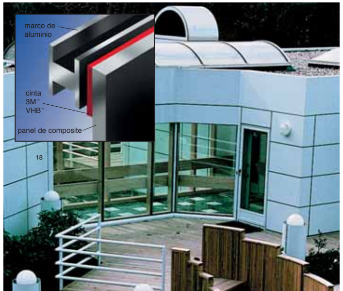
Edificio Shaffner St Joseph, MI, USA Arquitecto: Shaffner and Associates, 1986 Paneles de aluminio unidos a estructura de aluminio
