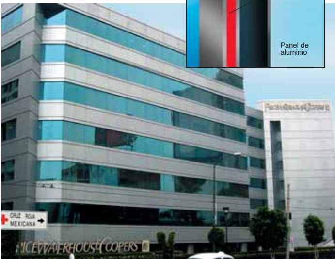
Price Waterhouse, Ciudad de Méjico, Méjico Construcción: Salvador Díaz Dupont, 2001 Paneles de aluminio unidos a estructura
