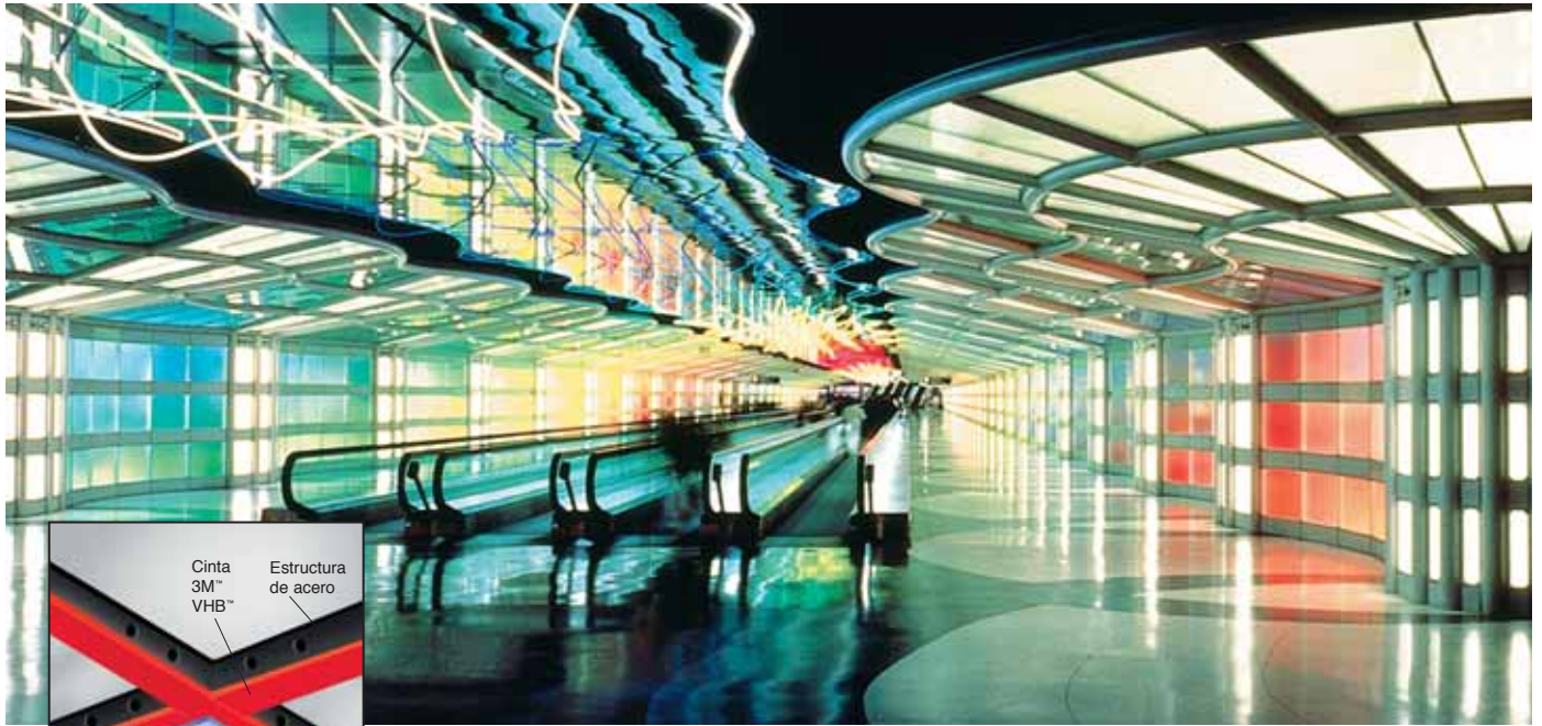
Aeropuerto O'Hare Chicago, Illinois, USA Arquitecto: Custom Products of SouthGate, CA, 1987 Paneles compuestos con acabado espejo pegados a estructura de techo en suspensión
