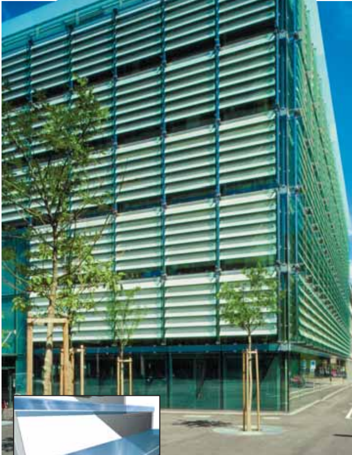
Edificio Tamedia, Zurich, Suiza Diseño fachada: Soder AG Año 2001 Escalones de vidrio pegados a marco de acero barnizado
