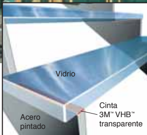
Edificio Tamedia, Zurich, Suiza Diseño fachada: Soder AG Año 2001 Escalones de vidrio pegados a marco de acero barnizado
